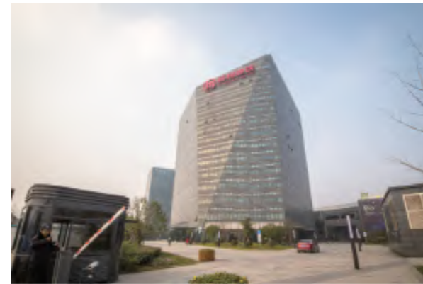
杭州地铁办公楼
