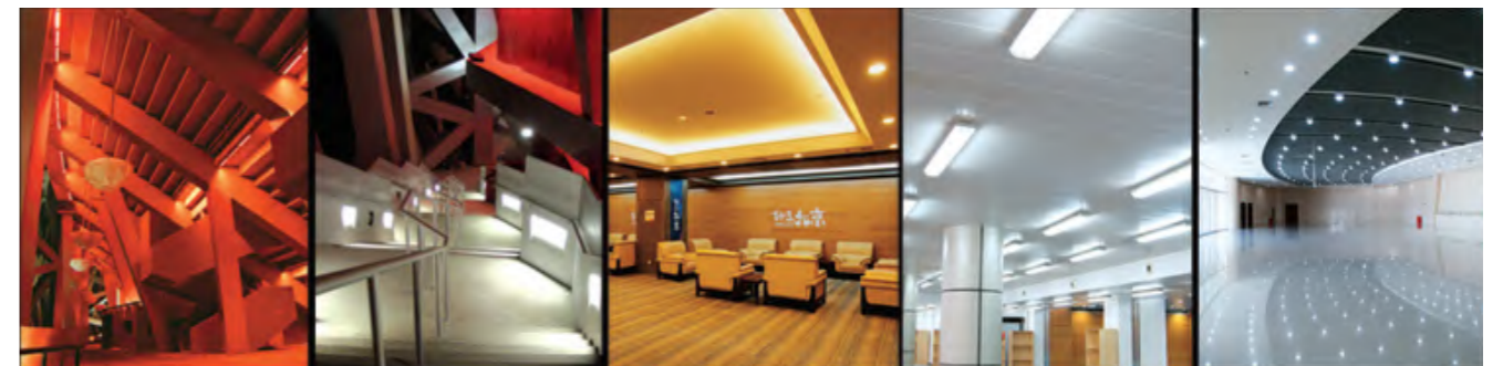
灯光调试现场图
